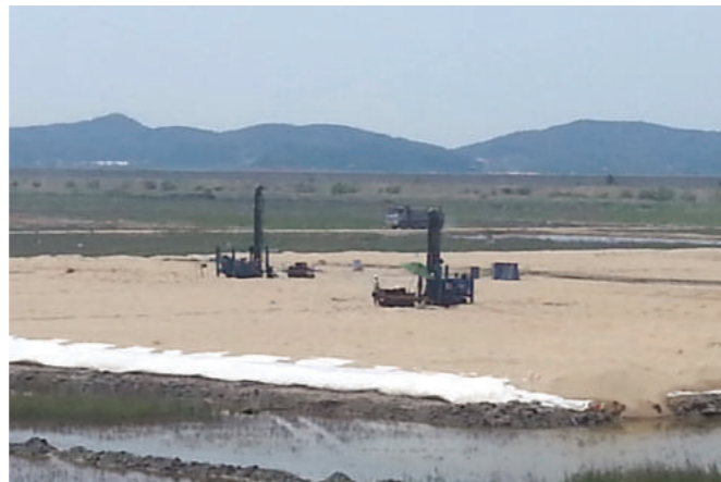
배수재 포설 및 시공 완료
